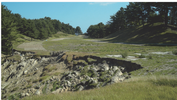
2011年(H23)3月11日14時46分、東北地方太平洋岸沖で発生した東日本大震災。コースが大きく崩壊した宮城野GC西コース2番ホール
